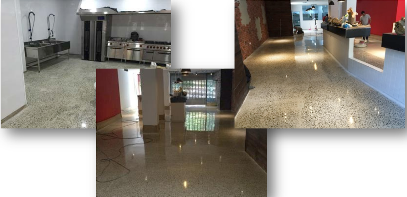
Impermeabilización y pulido de solera en restaurante.
