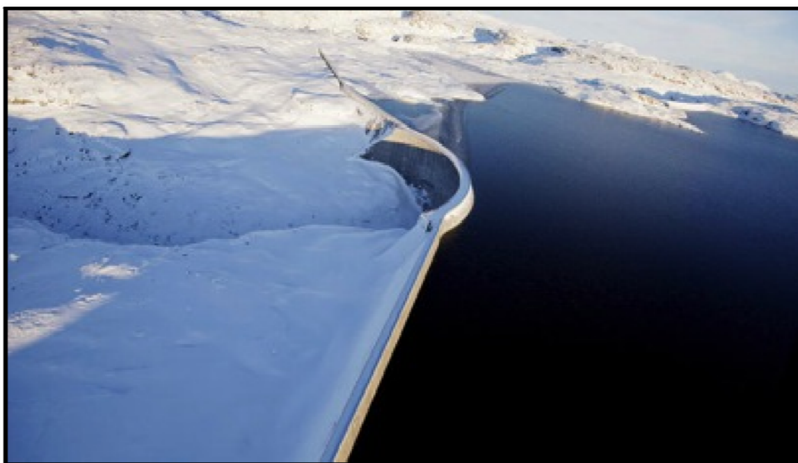
PRESA FORREVASSDAMMEN - AKAM
