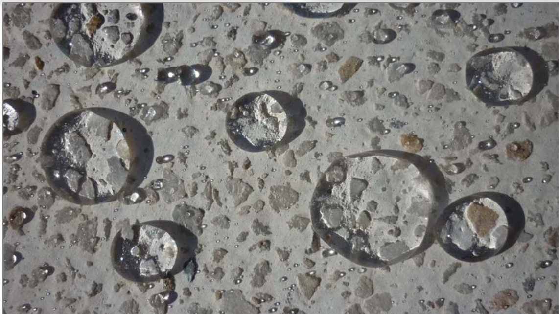
Tratamiento de CONTROLL®TOPSEAL en pieza de coronación de la piscina
