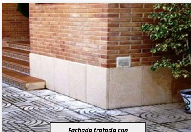
Fachada tratada con CONTROLL®TOPSEAL
