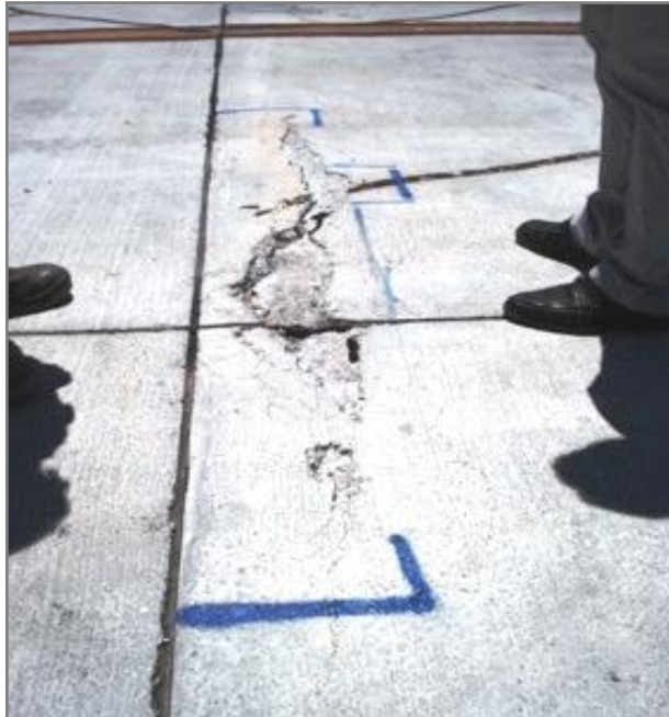
FISURAS EN LOSAS DE HORMIGÓN
