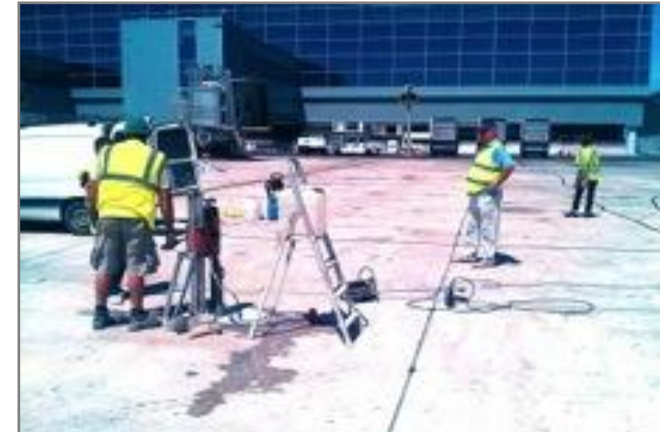
EXTRACCIÓN DE TESTIGOS
