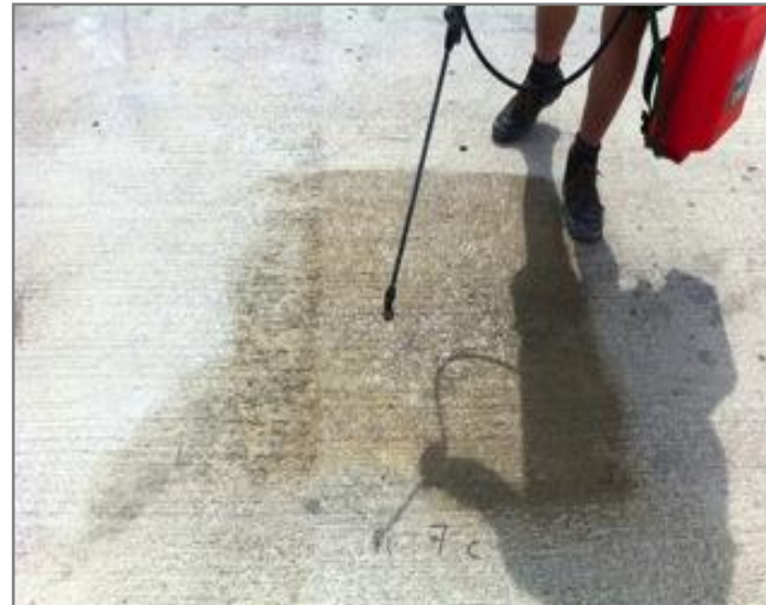
APLICACIÓN DE CONTROLL®INNERSEAL
